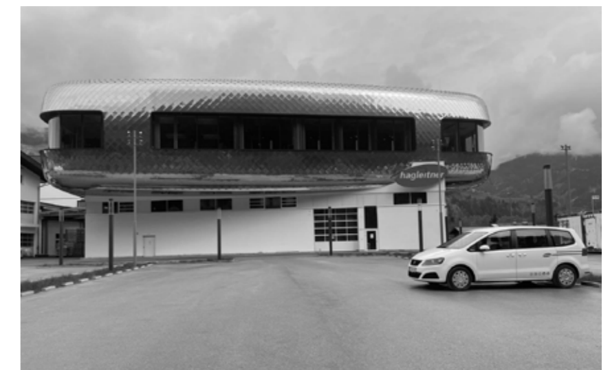
Neuer Zusatzbau des Betriebs.
